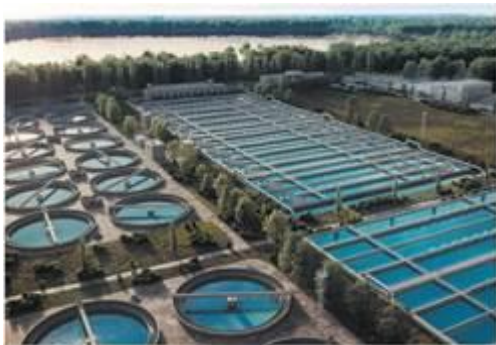
Станція для очищення стічних вод
